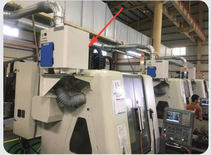
標準中央配管工程
