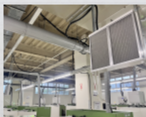
安裝導油管，排除過濾設備所捕集的油滴。
