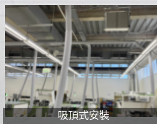
安裝導油管，排除過濾設備所捕集的油滴。
